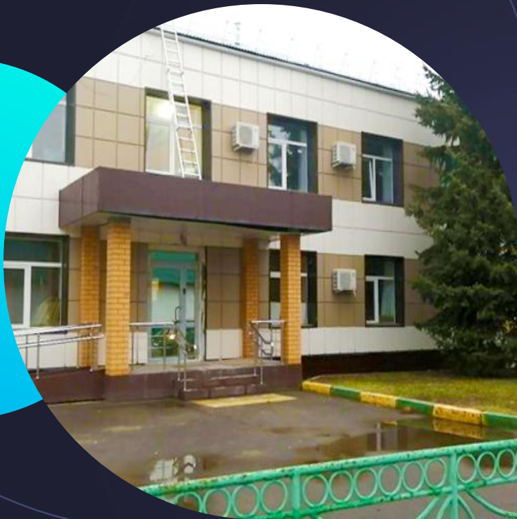
Капитальный ремонт Рыболовской амбулатории
