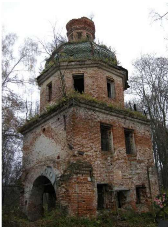
Вид с юго-запада
