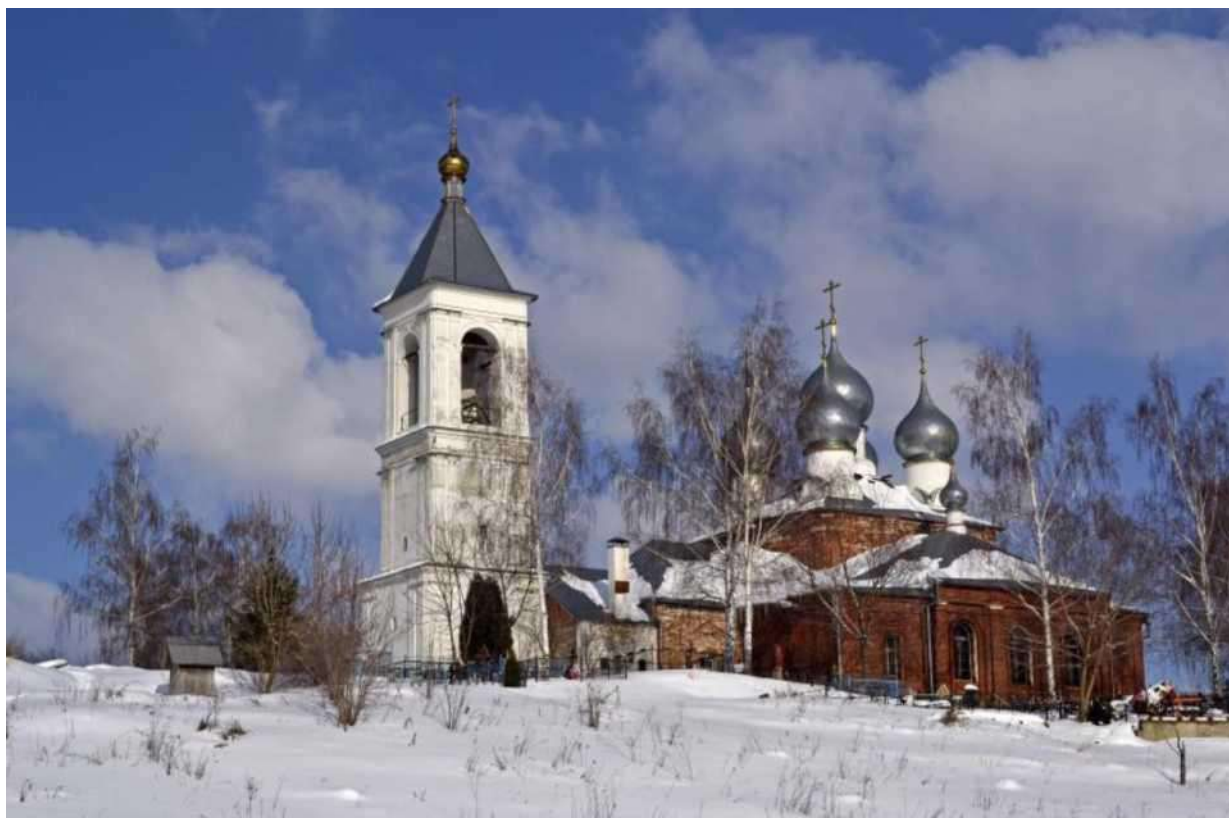
Никитская церковь, 1770 г., с. Софьино. Южный фасад.
