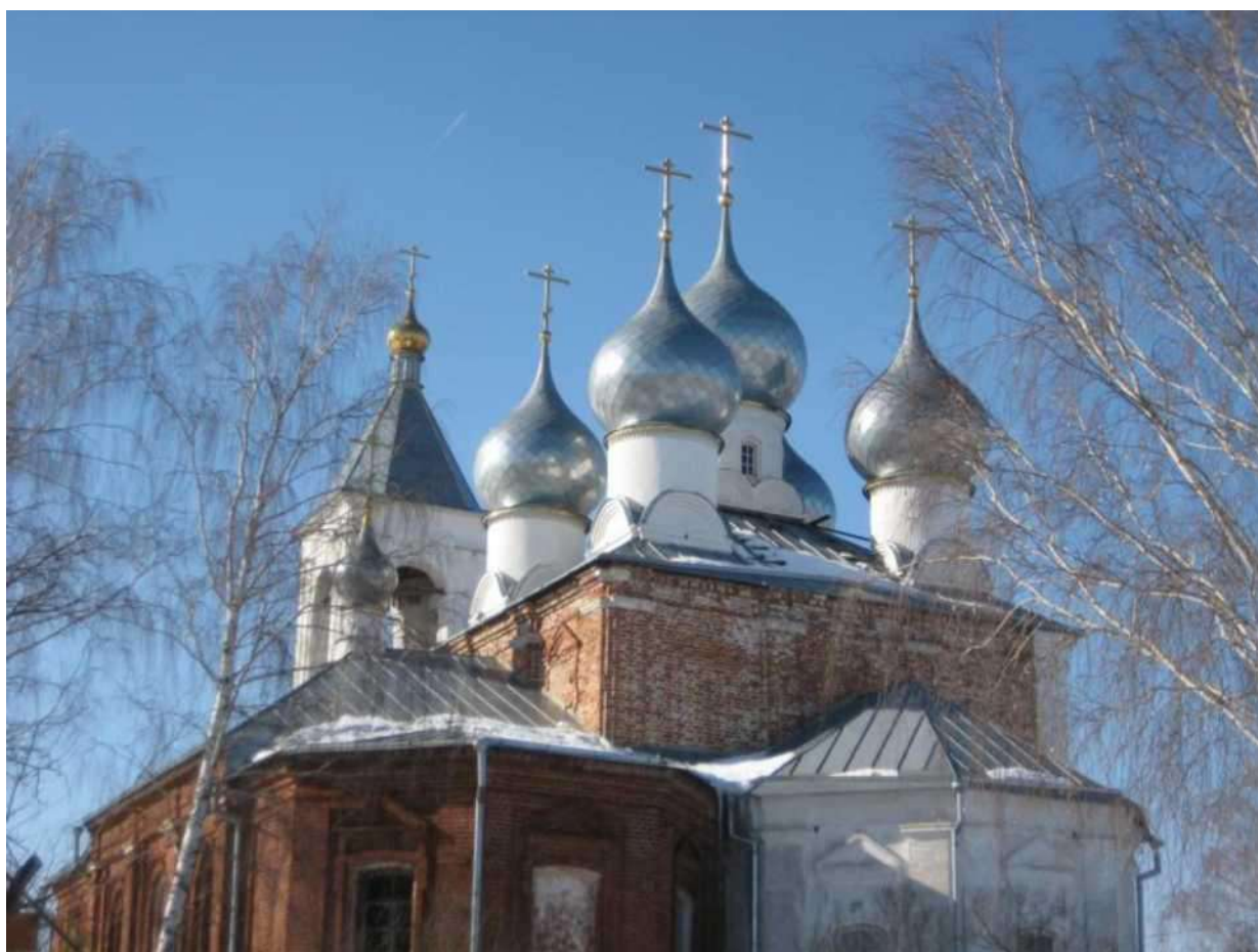
Никитская церковь, 1770 г., с. Софьино. Северный фасад
