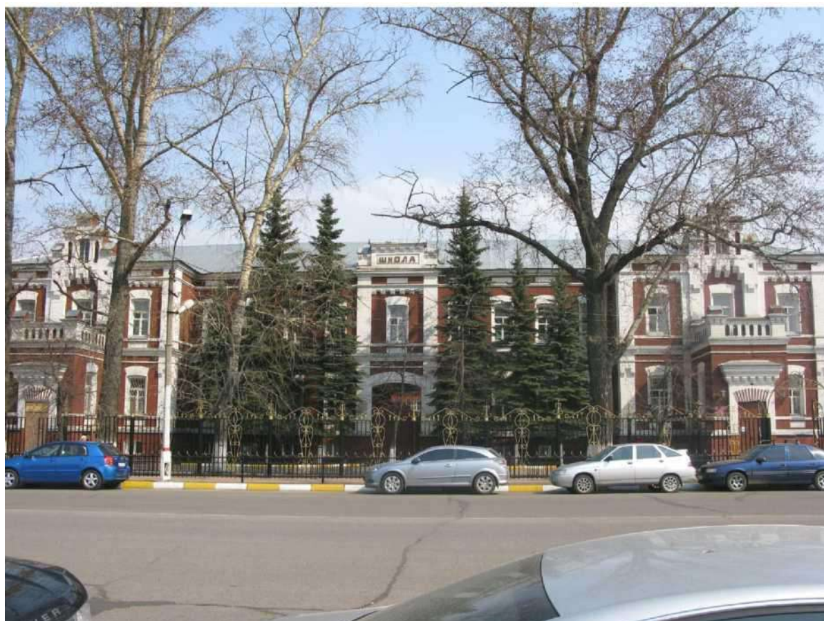
Вид с юга на южный фасад
