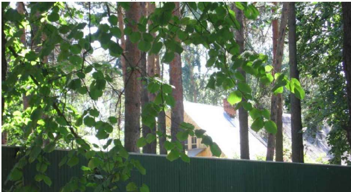
Вид на крышу памятника с северо-западной стороны
